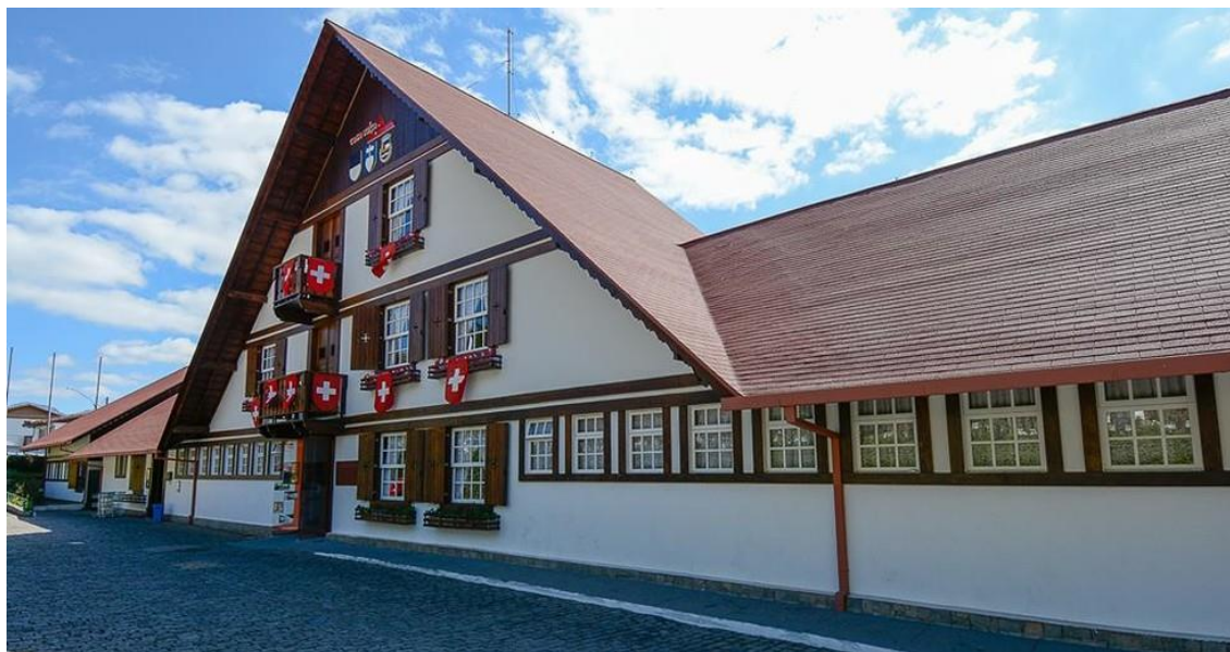
Figura 1 – Casa em estilo suíço, Nova Friburgo, Rio de Janeiro
